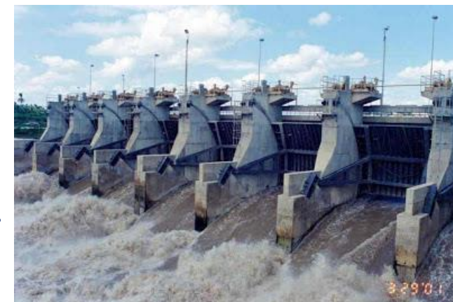
Presa de derivación Sullana vulnerable
